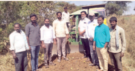
ఫార్మిషన్ రోడ్డు పనులను ప్రారంభిస్తున్న కోహార్ శ్రీనివాస్
